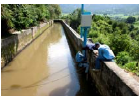
Instalación del equipo Doppler lateral.
