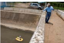
Aforo de calibración del medidor instalado en el km 21+740.
