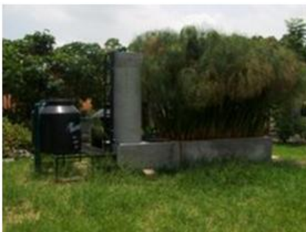
Acoplamiento del humedal con el biofiltro.
