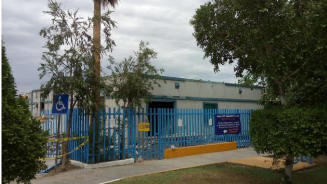
Zona Comercial III, antes de remodelar.
