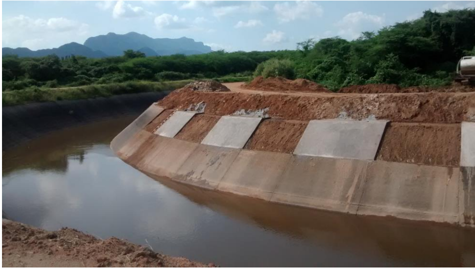
Sobreelevación y rehabilitación de losas dañadas.
