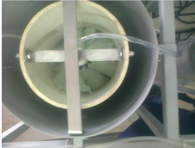
Vista superior del biorreactor empacado antes del arranque.
