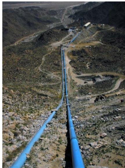
Vista panorámica del acueducto.
