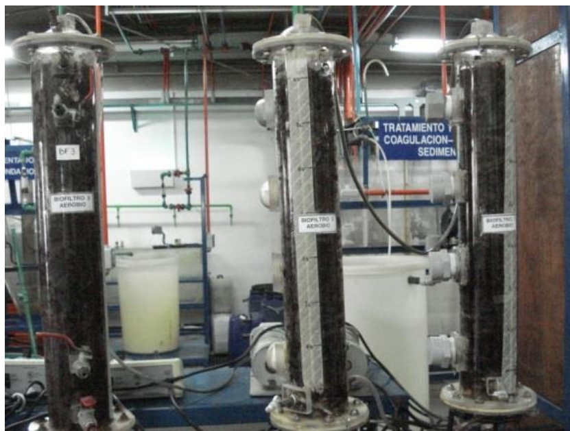
Sistemas de biofiltración para remover contaminantes emergentes.
