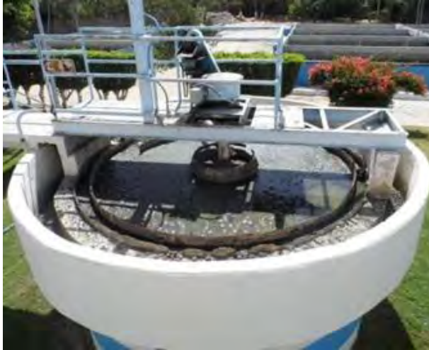
PTAR San José del Cabo, Baja California Sur.
