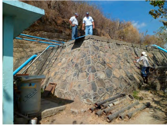
Revisión de la infraestructura para agua potable.
