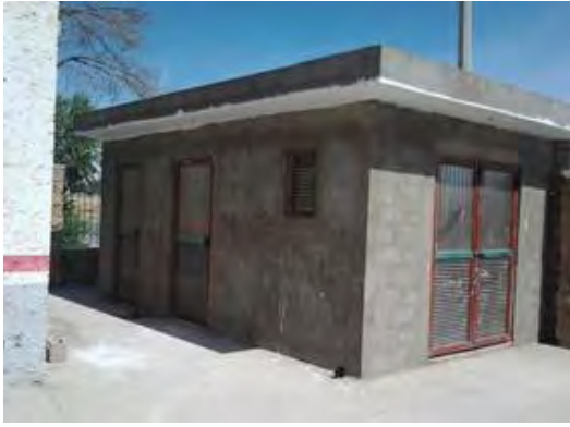
Cuarto de control para las plantas potabilizadoras a pie de pozo.
