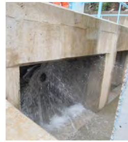
Válvula de chorro hueco.
