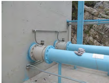
Medidores electromagnéticos.
