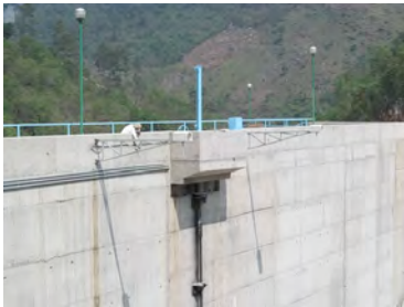
Sensor de nivel en presa.
