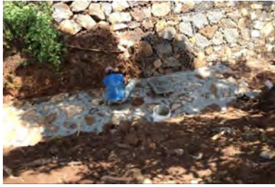
Acondicionamiento del colchón hidráulico.
