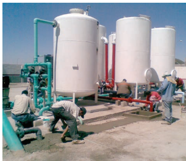
Instalación de los filtros.
