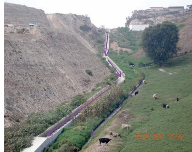
Canal de estructura escalonada con flujo de agua tratada.
