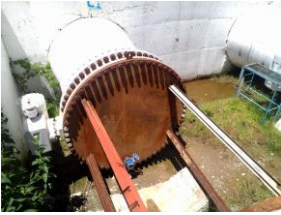
Preparación para conexión de la línea 3, desde la planta de bombeo 5.
