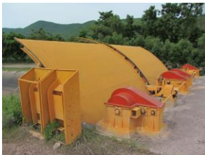
Rehabilitación de represa en el canal principal Humaya.
