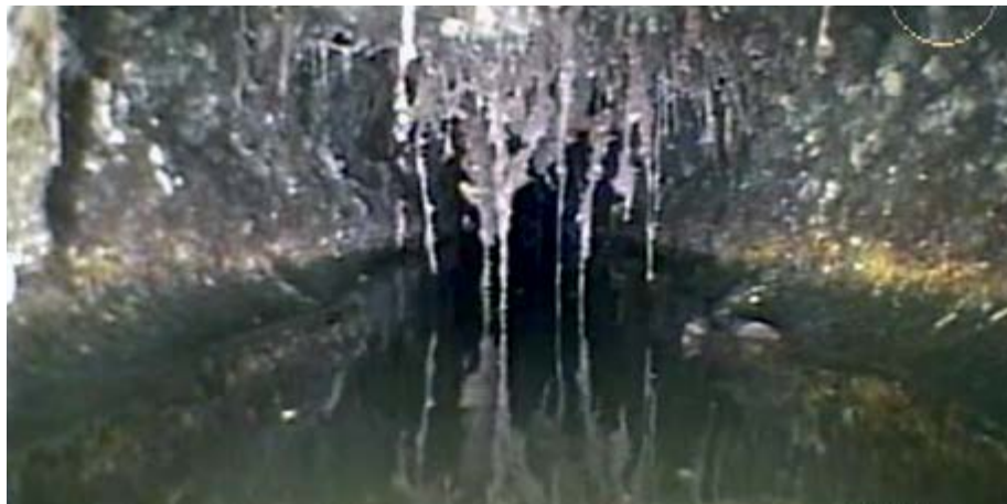
Inspección con equipo robótico.
