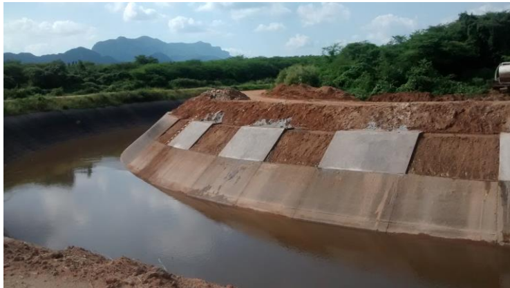
Sobreelevación y rehabilitación de losas dañadas.
