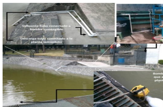
Instalación de la planta semipiloto
