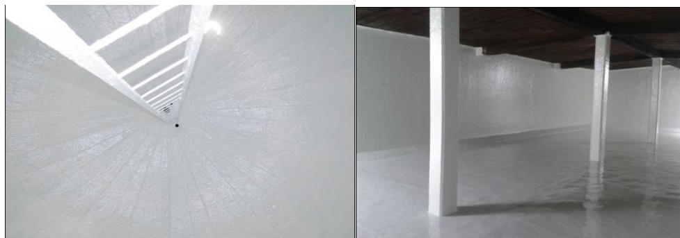
Rehabilitación de tanques (metálico y mampostería) con VITROACERO®
