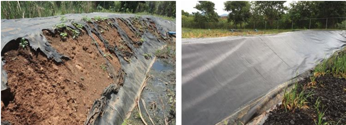
Trabajos de mantenimiento, San Jerónimo Purenchécuaro D1
