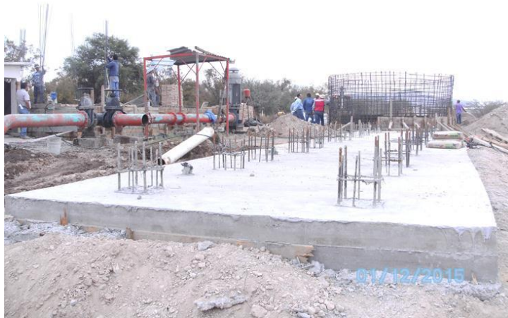
Ejecución de obra en Pozo Alamito, Francisco I. Madero, Coahuila
