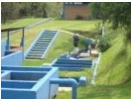
Planta de tratamiento de agua residual Rastro, Valle de Bravo, Estado de México.
