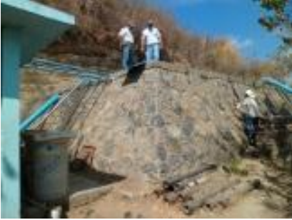
Revisión de la infraestructura para agua potable.
