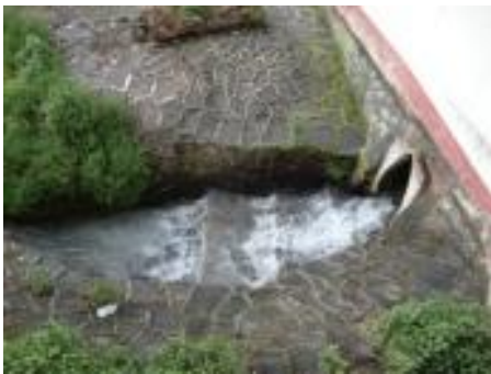
Descarga de agua residual doméstica y agua pluvial, La Pera (Embarcadero), Valle de Bravo, Estado de México.
