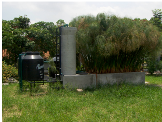
Acoplamiento del humedal con el biofiltro.
