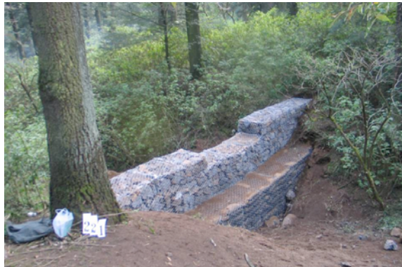
Represa de gavión con refuerzo de geocostales en la subcuenca del río Eslava, Distrito Federal.
