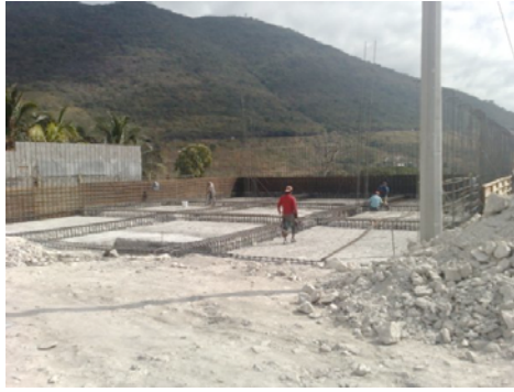
Vista del Tanque Granjas Alto en construcción.
