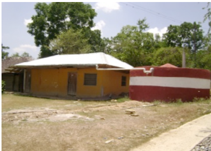
Cisterna de 50,000 litros y sistema de captación en Santa Martha.
