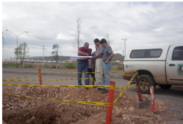
Recorrido en campo y análisis de las estructuras de protección.
