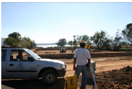
Instalación del humedal en San Jerónimo Purenchécuaro.
