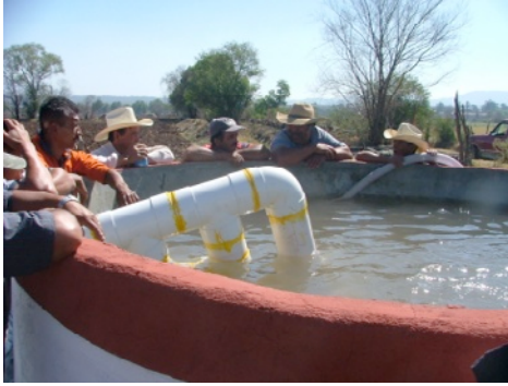
Etapa de llenado del tanque de descarga de fondo para riego parcelario en El Jagüey, Tzinzunzan.
