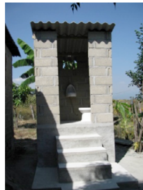
Sanitario ecológico seco en la colonia Santa Úrsula de Temixco.
