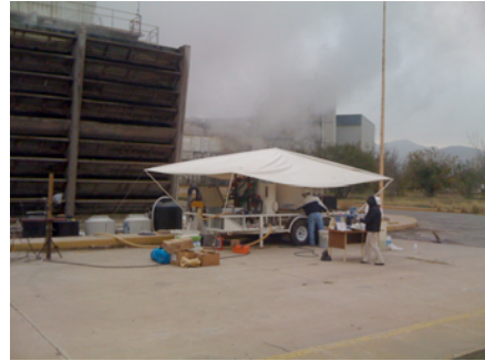
Planta piloto acoplada a la torre de enfriamiento de la central termoeléctrica Guadalupe Victoria, Comisión Federal de Electricidad en Lerdo, Durango.
