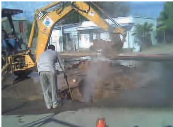
Reparación de la fuga ubicada en Av. Guadalupe Victoria con Calle 15.
