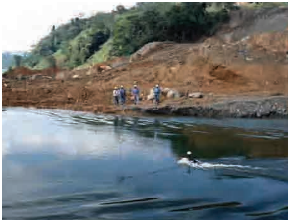
Aforos en el canal San Juan de Grijalva.
