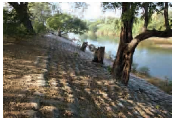
Reforzamiento de cauce con colchacreto.
