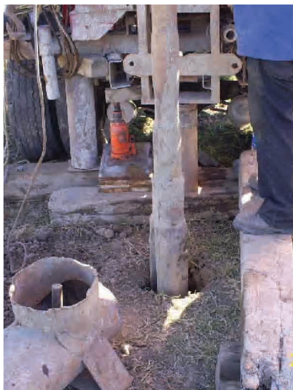
Perforación de piezómetros.
