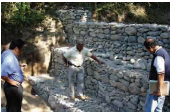
Represa filtrante de gavión. Espigón para protección de viviendas y talud de cauce.
