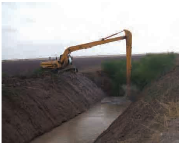
Rehabilitación de drenes en el Módulo VII-1 Juncos, del D. R. 075 Río Fuerte, Sinaloa.
