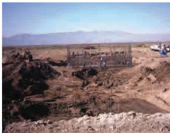
Construcción de la planta de bombeo del km 19+200.
