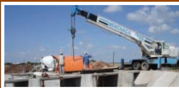
Registro de cambio de compuertas radiales en un canal principal en el distrito de riego 038 Río Mayo, Sonora.
