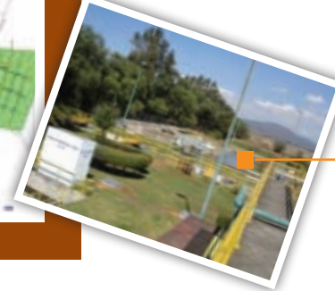
Planta de tratamiento Las Garzas, rehabilitada.
