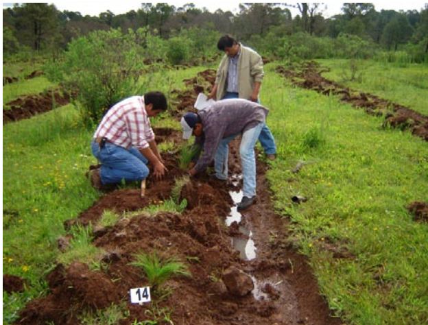
REFORESTACIÓN CON ZANJAS DE INFILTRACIÓN. CUENCA DEL LAGO DE PÁTZCUARO, MICHOACÁN
